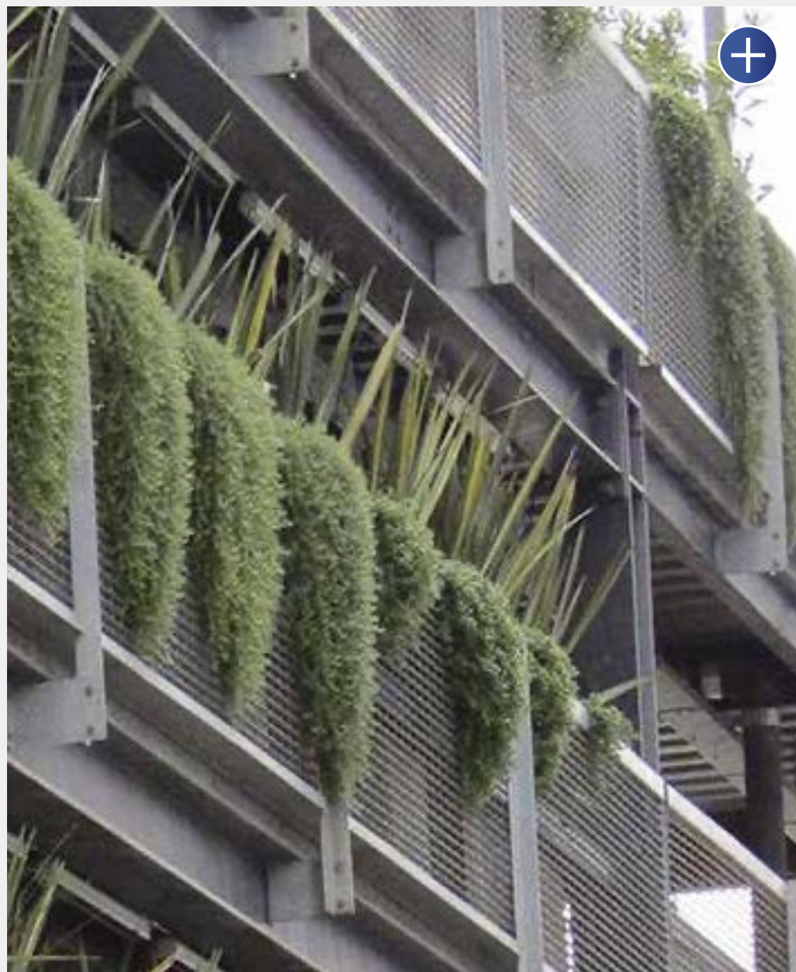
Estacionamiento Punta Carretas
